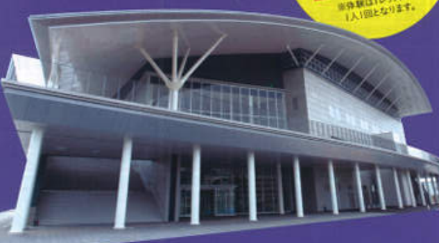
高気圧防湿気密構造 TOBIUME ARENA 太宰府市総合体育館
